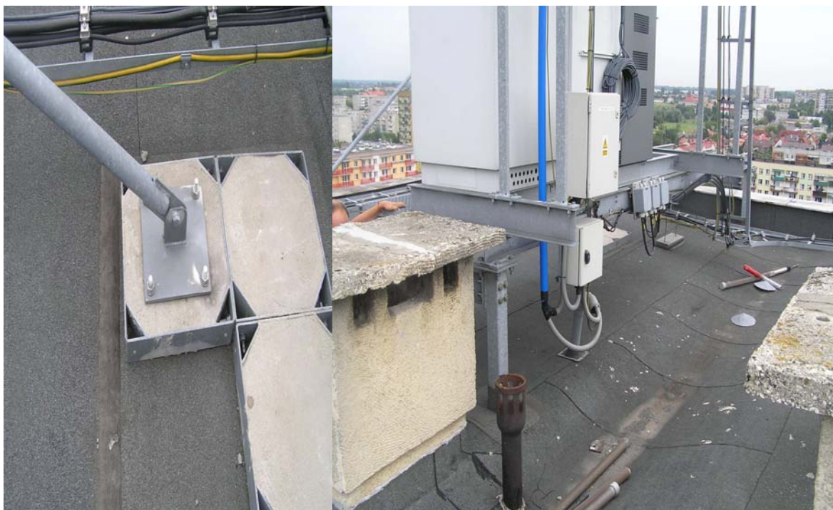
Fot.5, Fot.6. Widok sposobu montażu istniejących urządzeń na stropodachu.
