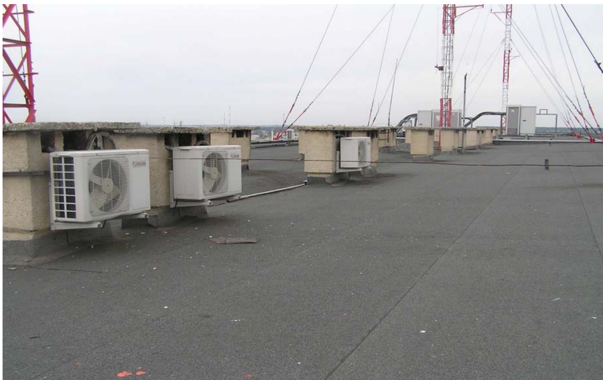
Fot.3. Widok fragmentu dachu objętego opracowaniem.
