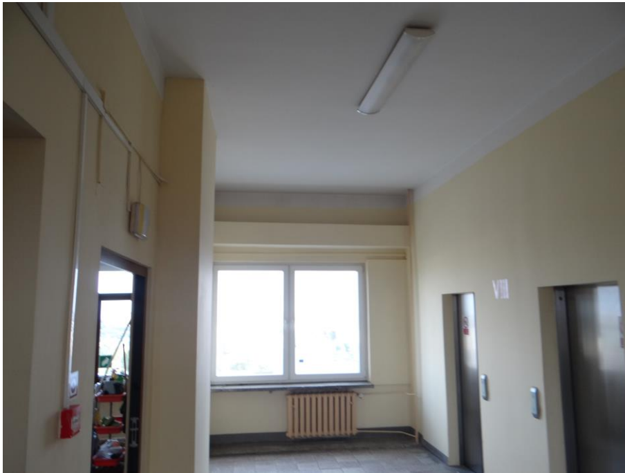
Fot. 1. Piętro VIII – widok na strop podlegający rozbiórce.
