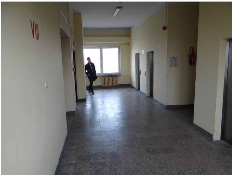
Fot. 2. Piętro VIII – widok na przestrzeń korytarza do zabezpieczenia podczas wykonywania robót rozbiórkowych.
