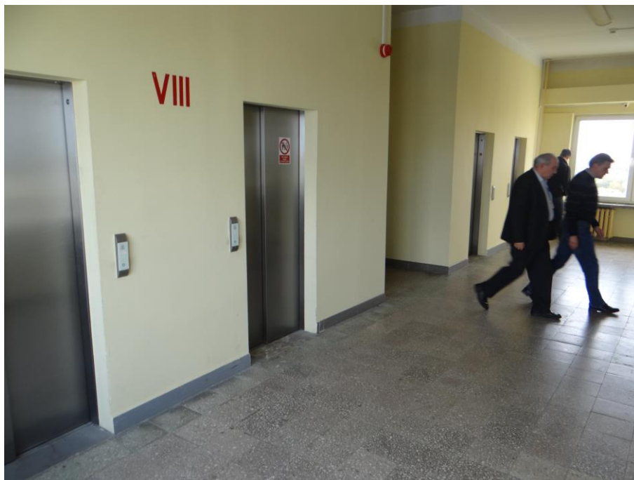
Fot. 3. Piętro VIII – widok na windy osobowe do zabezpieczenia.
