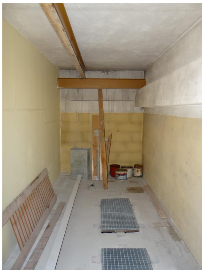
Fot. 4. Piętro IX – widok na maszynownię, otwory rewizyjne szybów windowych.
