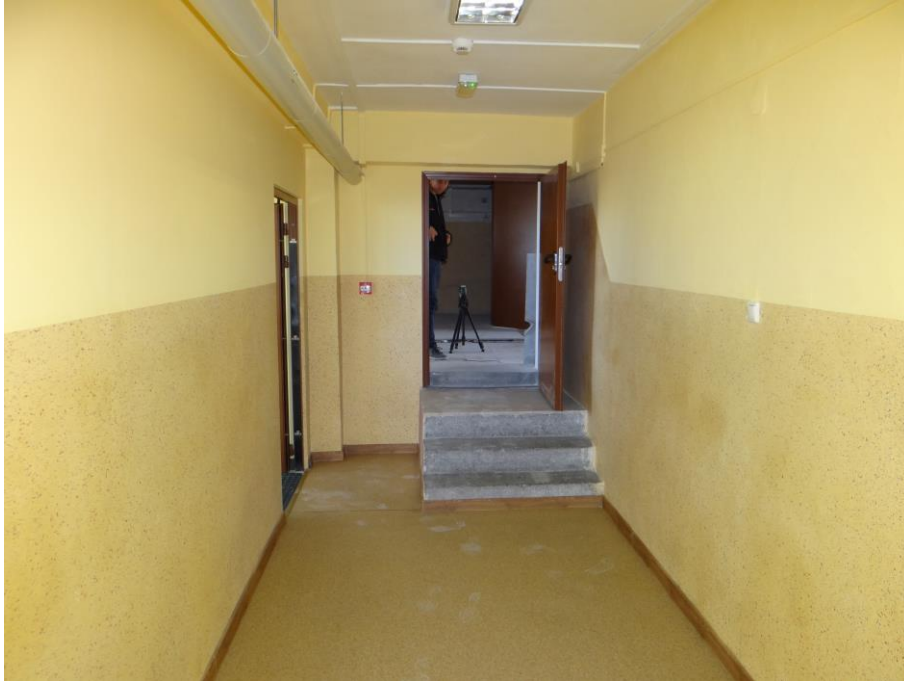
Fot. 7. Piętro IX – widok na schody, ścianę podlegającą rozbiórce.
