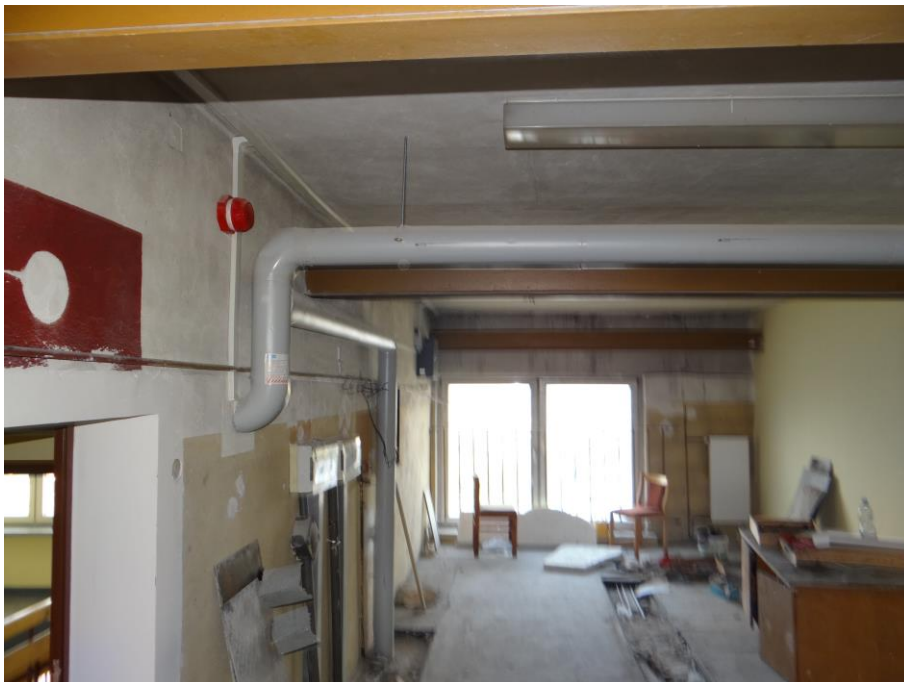
Fot. 6. Piętro IX – widok na przestrzeń planowanego wydzielenia pomieszczeń, widok na belki podlegające obudowie płytami gips-kartonowymi.
